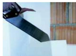
Applicare della malta adesiva sulla superficie d'incollaggio del blocco di montaggio MTH QUADRO PU. L'elemento deve essere completamente incollato su tutta la superficie della base.
