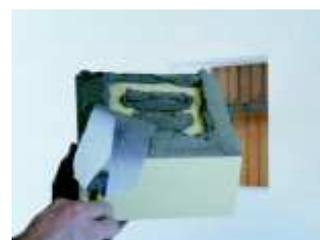
Premere i blocchi di montaggio MTH QUADRO PU a filo dei pannelli isolanti.
